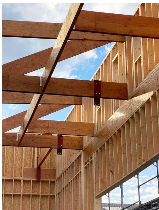
カナダ産 OSB と SPF の壁パネル、ベイマツ LVL のトラスで構成されたツーバイフォー工法の木造倉庫。
