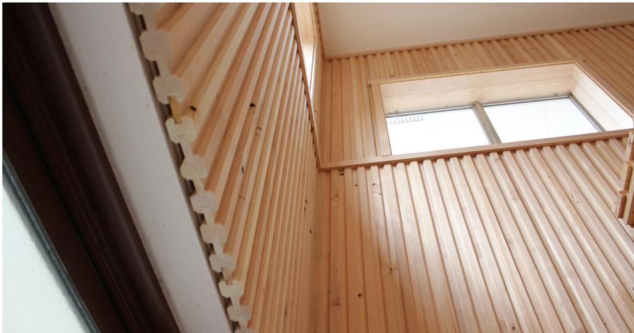
▲羽柄材として製材されたカナダツガ 45mm 角をモルダー加工し、同じくカナダツガ胴縁でジョイントして内装用パネルに成形しました。白木のカナダツガならではのやさらかな雰囲気空間にわたかみを与え、意匠的にも優れています。
