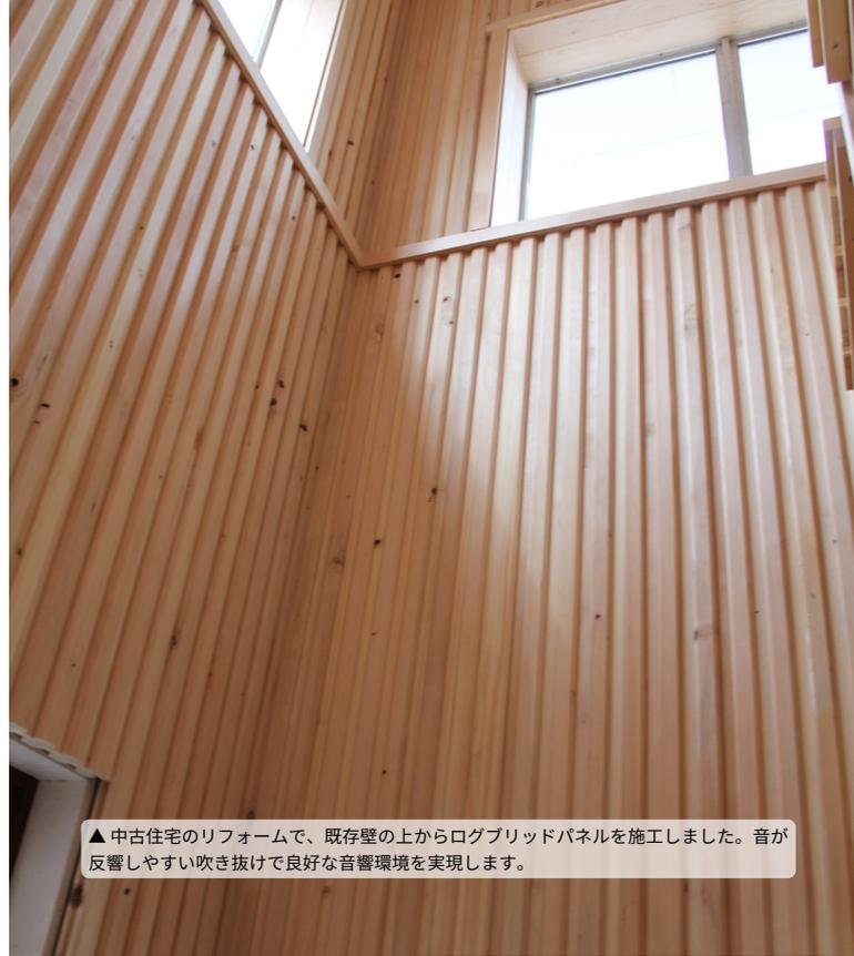
▲ 中古住宅のリフォームで、既存壁の上からログブリッドパネルを施工しました。音が反響しやすい吹き抜けて良好な音響環境を実現します。
