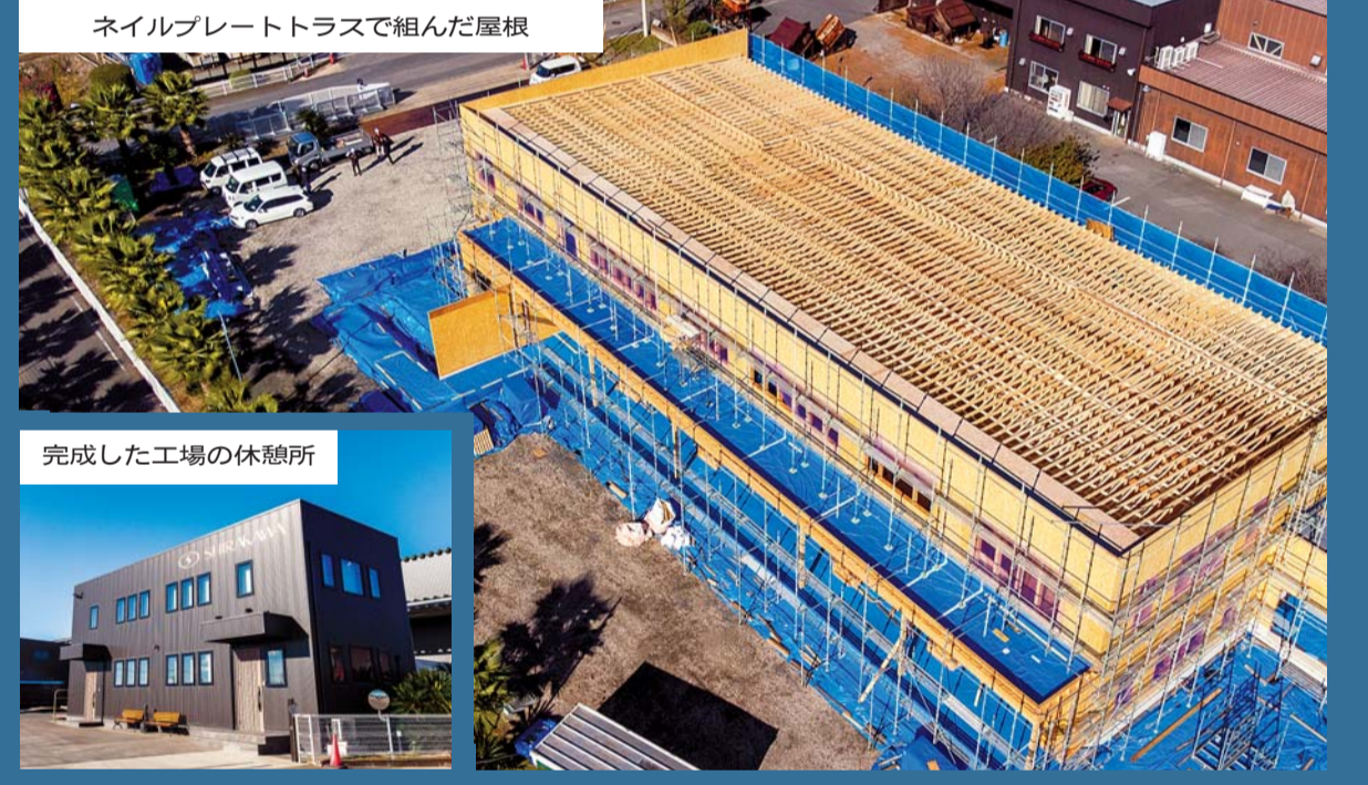
ネイルプレートトラスで組んだ屋根
