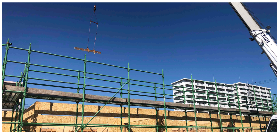
▲500㎡を超える事務所付き倉庫をツーバイフォー工法で建設します。カナダ産 OSB を使って躯体をパネル化し、施工の効率化とコストダウンを図りました。
