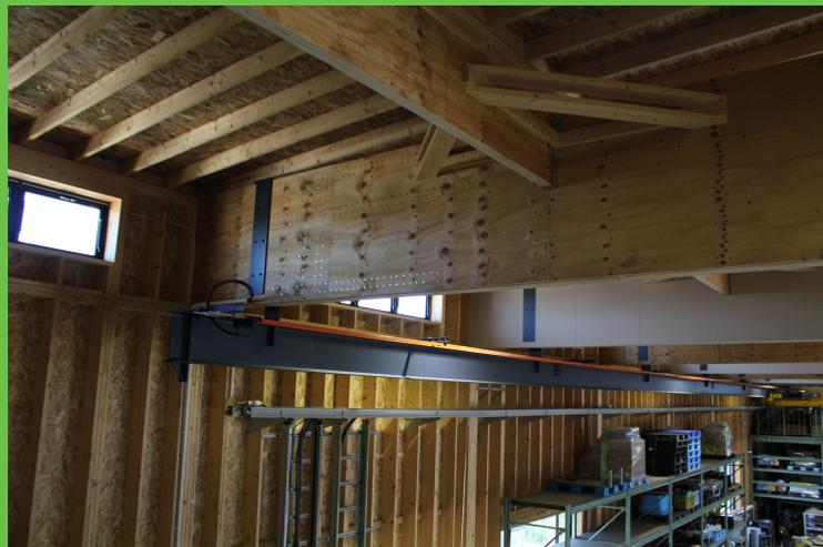
▲ 大型の LVL の梁で 15.5m スパンを飛ばし、ホイストクレーンを吊り下げています。
