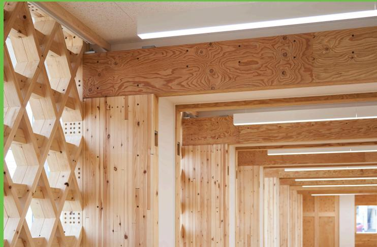
▲ 構造体となるラーメンは、耐火被覆したメインの大ラーメンに、水平力のみ分担するあらかしの小ラーメンを組み合わせました。住宅用木材を格子状に組み合わせた組子格子耐力壁は、壁倍率 35 倍の強度を持ちながら光が抜け、明るく開放的な空間を演出します。
