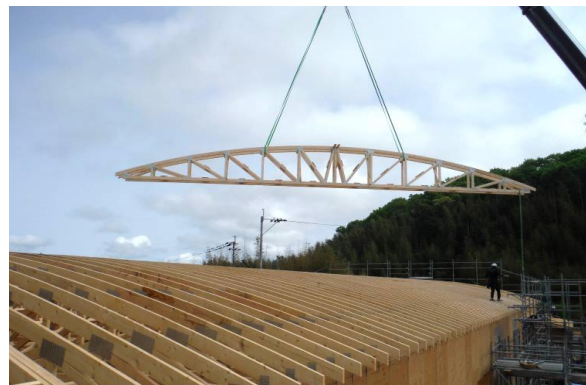
ボウストリングトラスの施工
