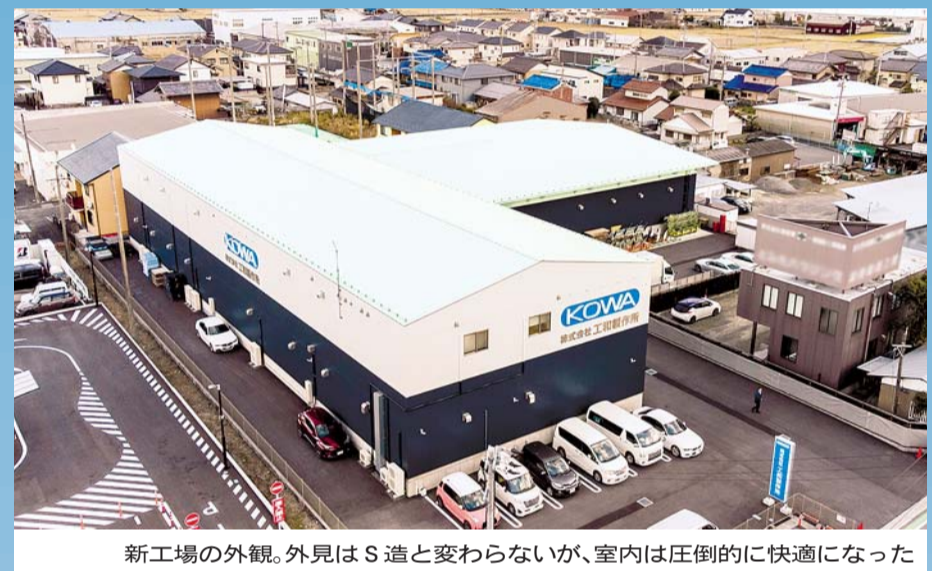
新工場の外観。外見はS造と変わらないが、室内は圧倒的に快適になった
