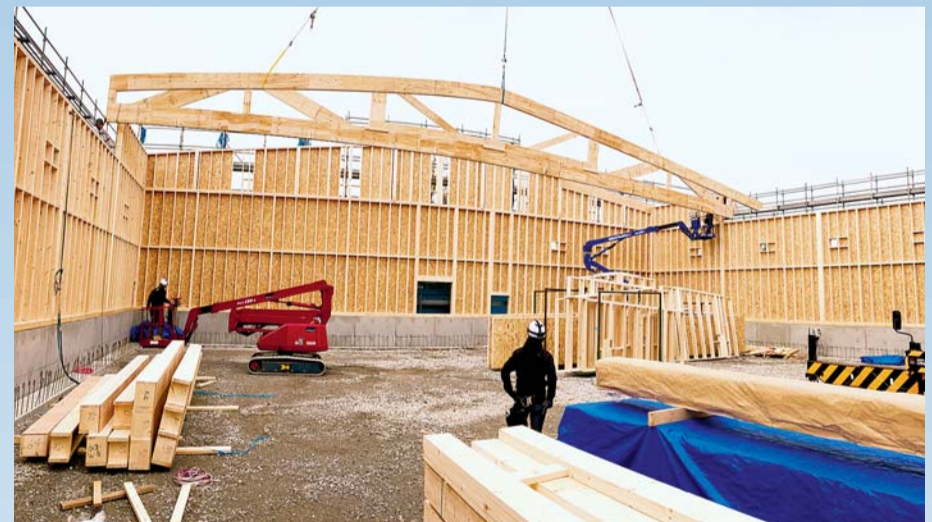
平屋部のトラスを設置している状況
