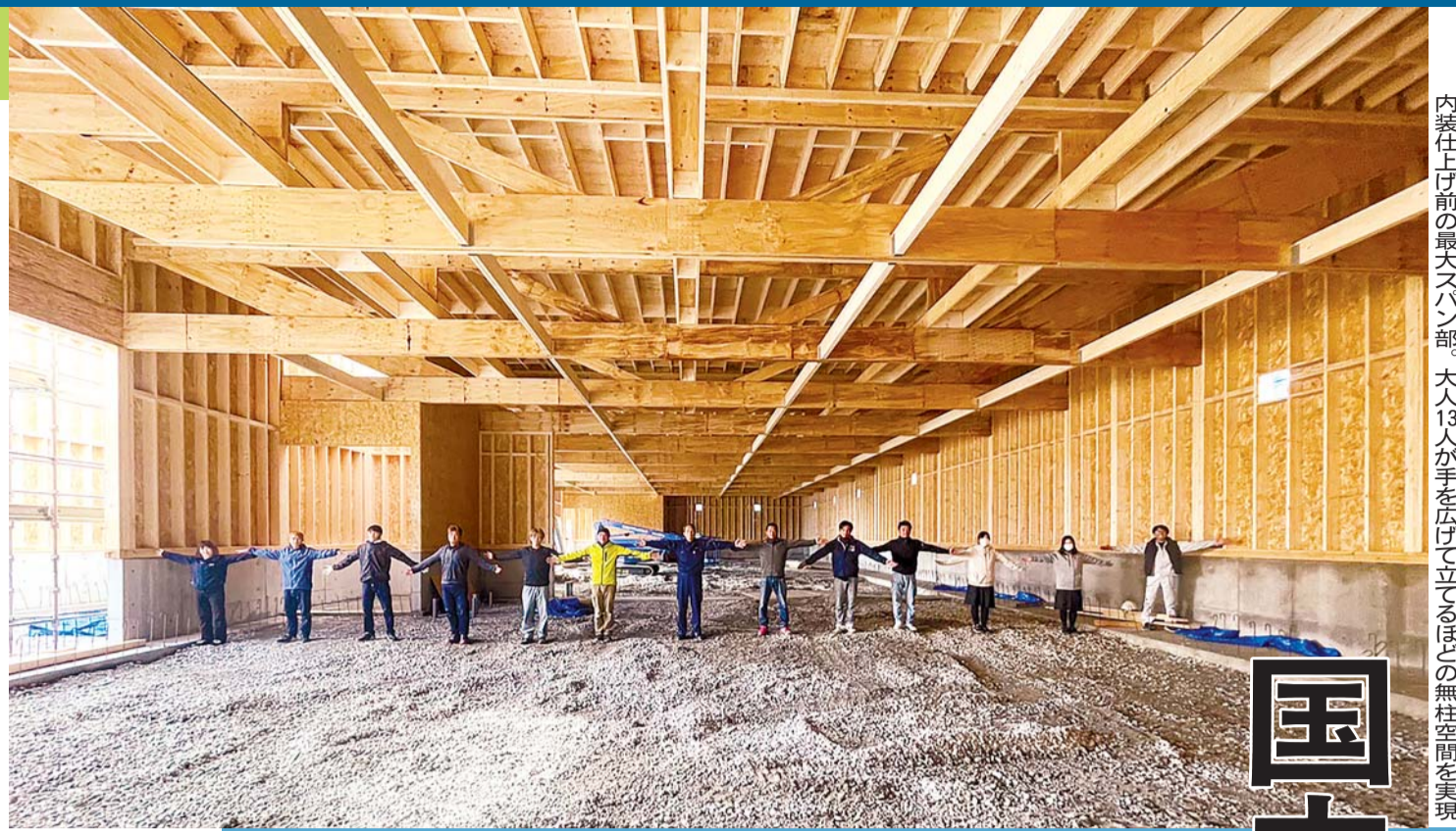
内装仕上げ前の最大スパン部。大人13人が手を広げて立てるほどの無柱空間を実現
