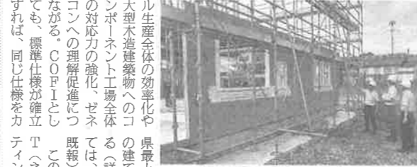
山形県での実証物件の建て方の様子
