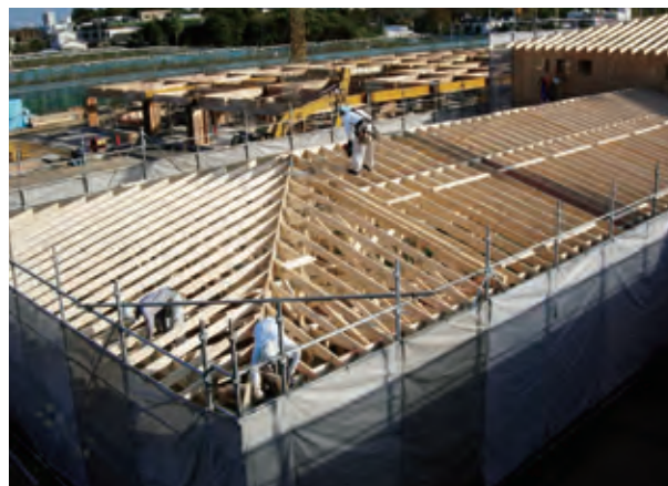
▲寄棟部のトラス設置事例
