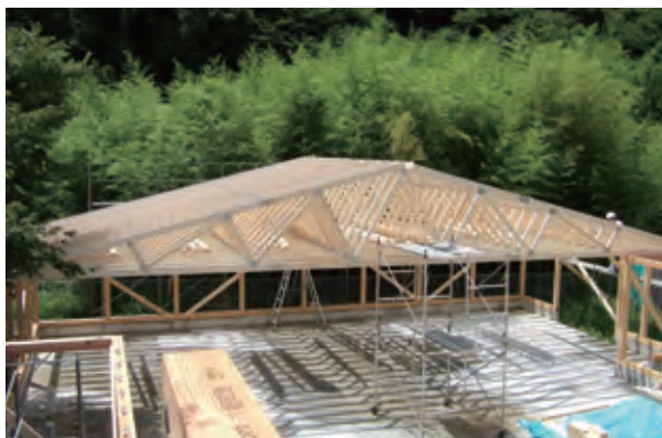
ダブルハウトラス スパンの目安:7.3~12.7m
