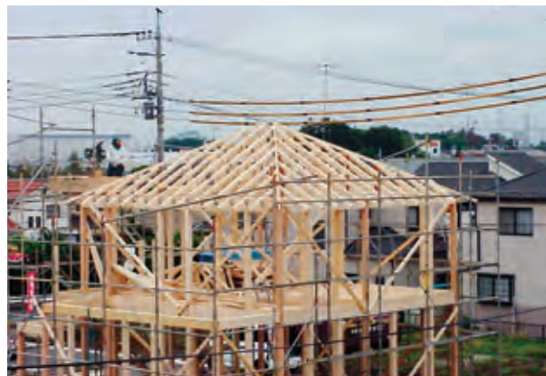
▲在来木造住宅に架構されたトラス
