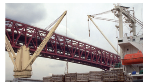
▲鉄橋などにもトラス構造が採用されています。
