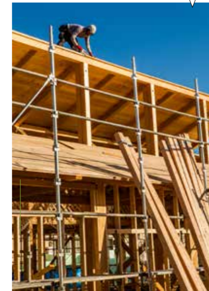
建設中の「どんぐり・アンみんなの図書室」。
