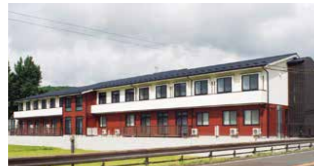
●入所定員：29床 ●構造：ツーバイフォー工法/木造耐火構造/2階建て ●施工：平成24年1月 ●竣工：平成24年6月 ●床面積：計1271.47㎡
