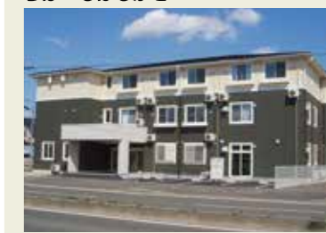
木造ツーバイフォー工法で建てられた 高齢者施設の事例
