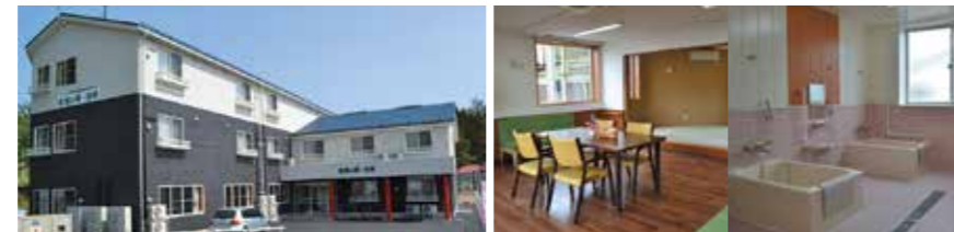
●事業者: FPホームサービス ●所在地: 岩手県盛岡市 ●構造: ツーバイフォー工法/木造耐火構造/3階建て ●設計・施工: FPホームサービス ●竣工: 2013年5月 ●建築面積: 1,056.87㎡ ●延床面積: 1,181.28㎡ ●併設: 通所介護事業所
