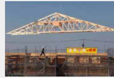
大規模ツーバイフォー工法の 大型屋根トラスの地組による合理化
