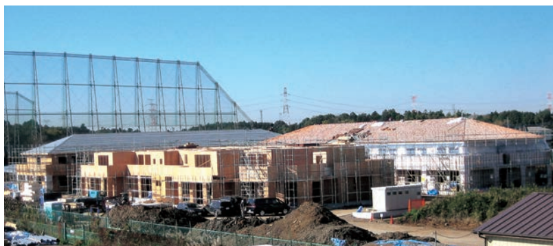
3棟で段階的に工事が進む様子が見える
