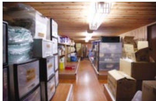
小屋裏部屋を確保できるのは、ツーバイフォーの構造的な特徴の一つ。備品の収納スペースをここに集約することができる。“2階建プラス小屋裏部屋”の3階建てがコスト的に最も経済的であると設計の段階で判断した。
