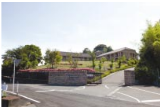
高台の斜面に立地しているため、エントランスから地下に当たるフロア（この階層はRC構造）にも自然光がたっぷり射す。
