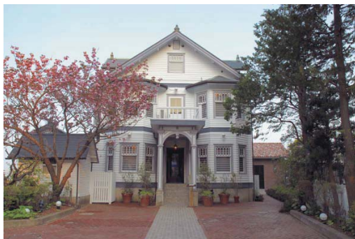
大磯町 旧木下邸 (大正元年の建築) 登録文化財 日本最古のツーバイフォー住宅
