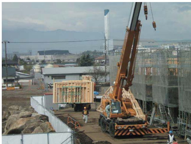
クレーンでのパネル・トラスの搬入
