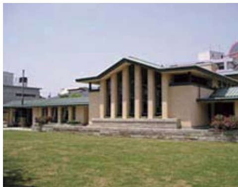
豊島区 自由学園 明日館 (大正10年建築) 重要文化財
