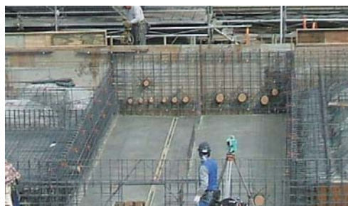
*適切に床下点検口設置・釜場設置
