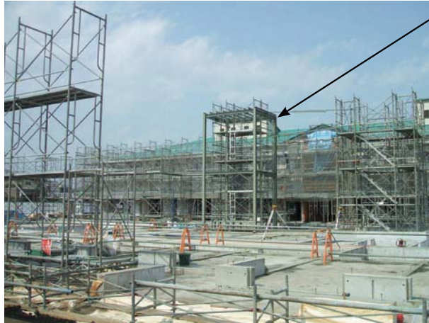
西棟エレベーター支持鉄骨施工状況
