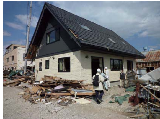
4mの津波に耐えたツーバイフォー住宅 (東日本大震災 石巻市)
