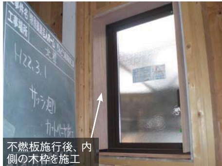
サッシ取付開口部の不燃板施工
