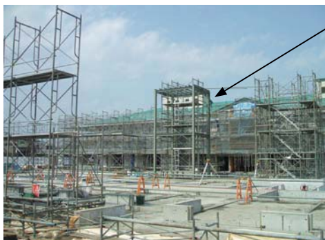
※エレベーター支持鉄骨施工状況
