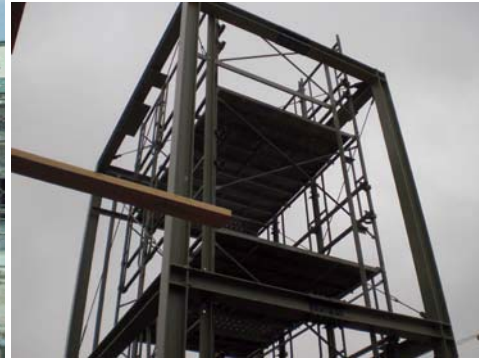
鉄骨フレーム内に仮設階段設置
