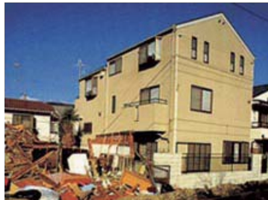
震度7の激震に耐えたツーバイフォー住宅（阪神・淡路大地震）
