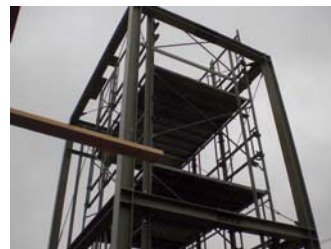
※鉄骨フレーム内に仮設階段設置
