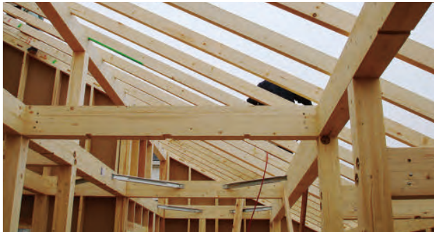
屋根垂木へ使用した事例(写真提供:株式会社ナカムラ)
