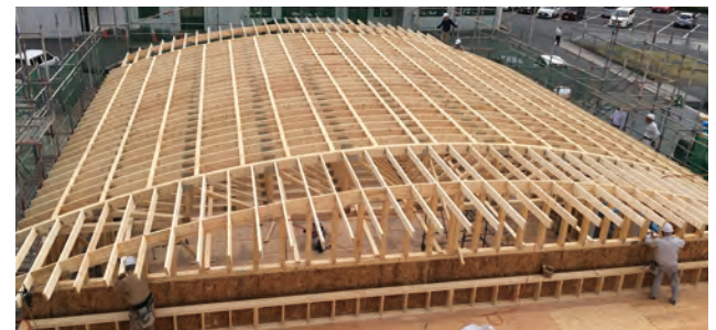
1階天井・2階床となる平行弦トラス(写真手前)をクレーンで吊り上げ並べていく。写真右奥は2階の屋根部分となるダブルフィンクトラス。(写真提供:プライムトラス株式会社)
