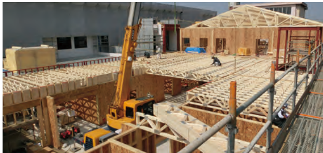
1階天井・2階床となる平行弦トラス(写真手前)をクレーンで吊り上げ並べていく。写真右奥は2階の屋根部分となるダブルフィンクトラス。(写真提供:プライムトラス株式会社)
