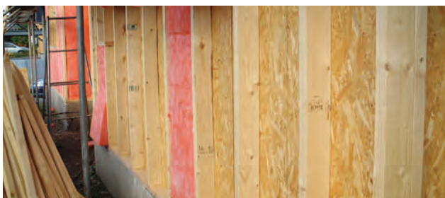
2層壁の間柱に使用して高断熱化を図った事例(写真提供:株式会社芦野組)
