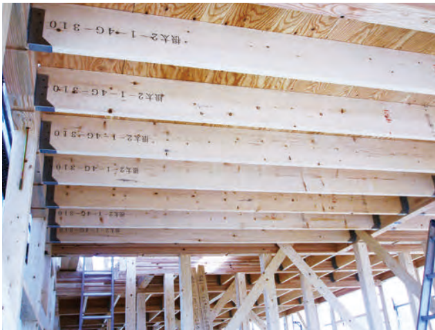
2×10を床根太に使用した事例(写真提供:福建ホーム株式会社)
